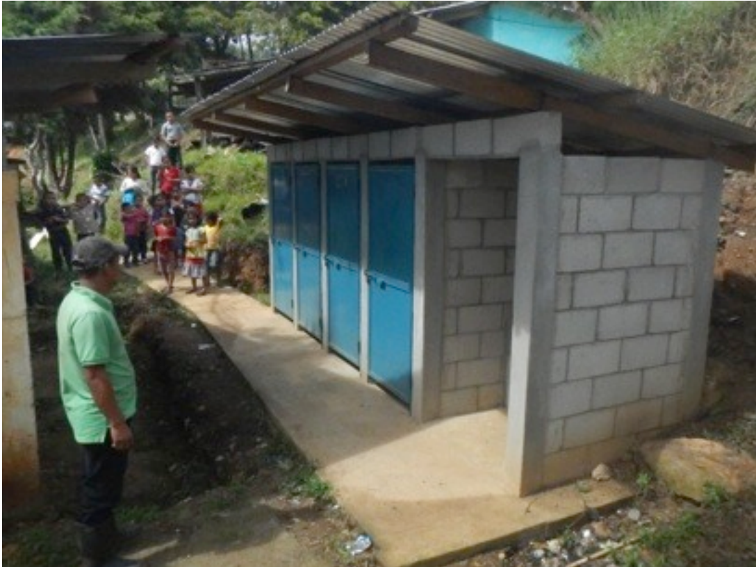
Die neuen Schultoiletten
